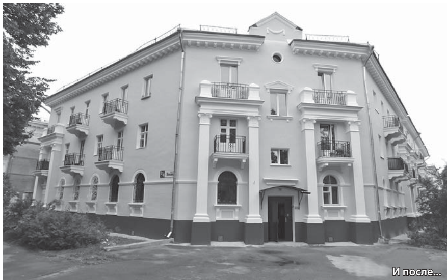
Обнинск, улица Ленина, 4 до капитального ремонта...
