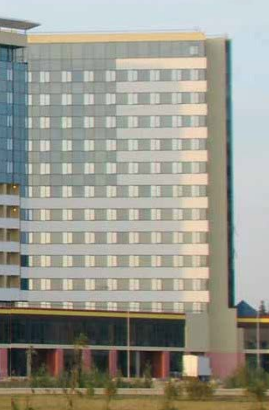
Жилой комплекс, облицовка фасада — АКП Alcotek, г. Ханты-Мансийск, 2010 г.
