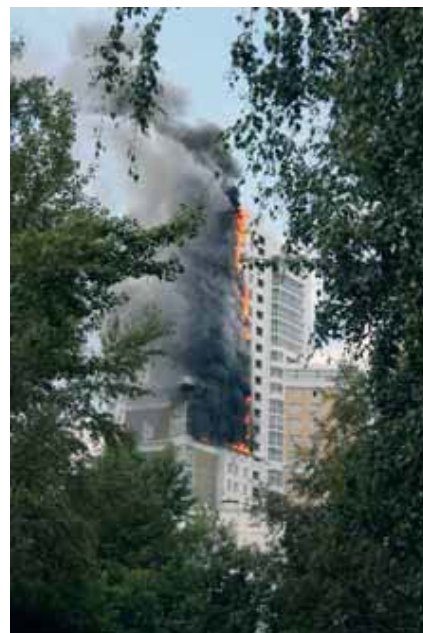
Новый 27-этажный жилой дом на улице Ивана Бабушкина, г. Москва, август 2009 г. Причина распространения огня по фасаду – использование в качестве облицовки АКП группы горючести Г4
